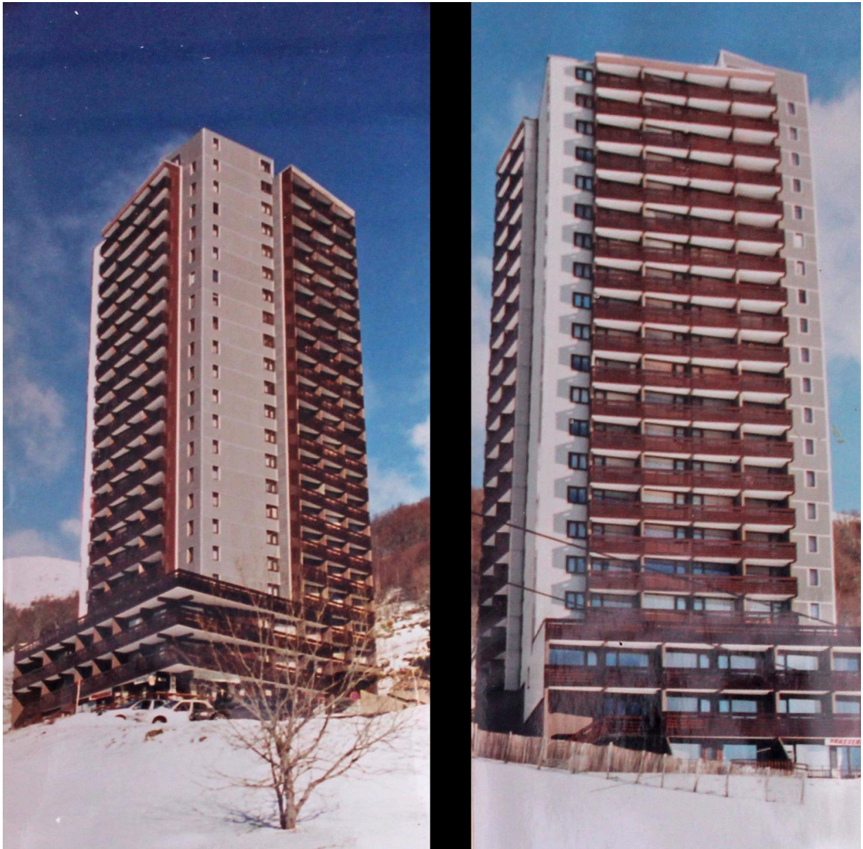
Super-Besse, la Tour de la Biche lors du remplacement du bardage extérieur des façades (le bardage d'origine, de couleur blanche, est encore en place sur l'angle ouest de la tour).
