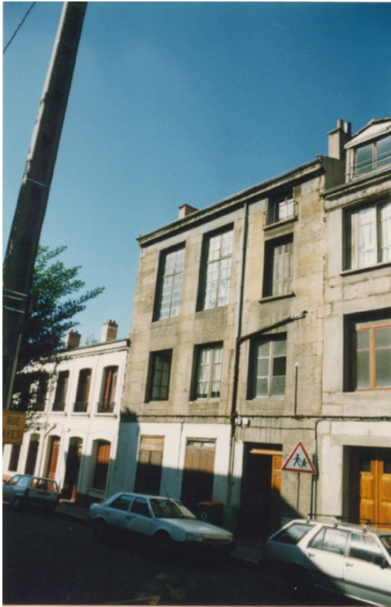
Elévation principale depuis le nord
