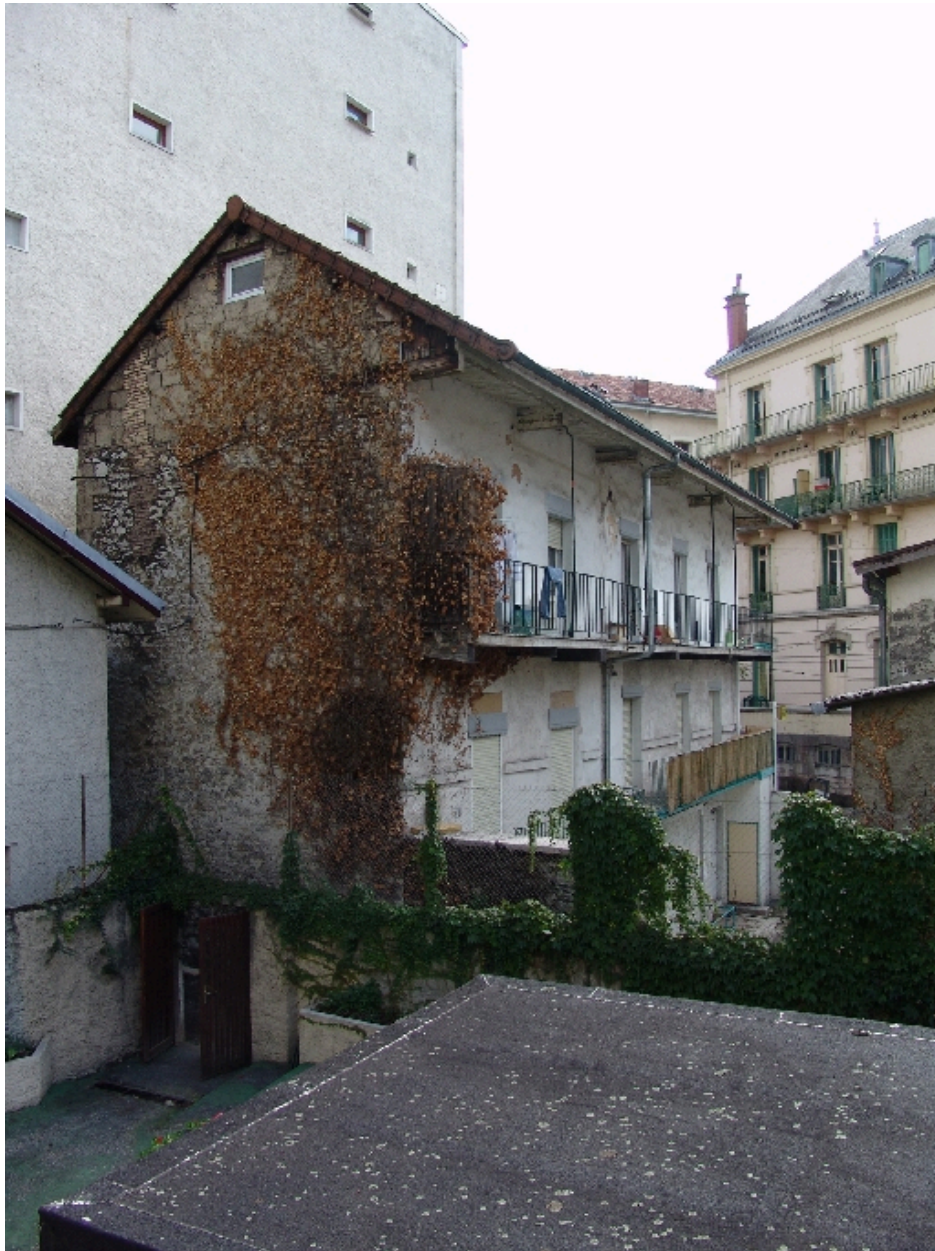
Vue générale depuis l'est
