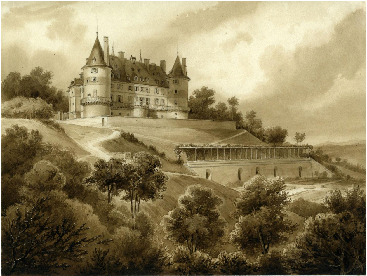
Vue sud après travaux
