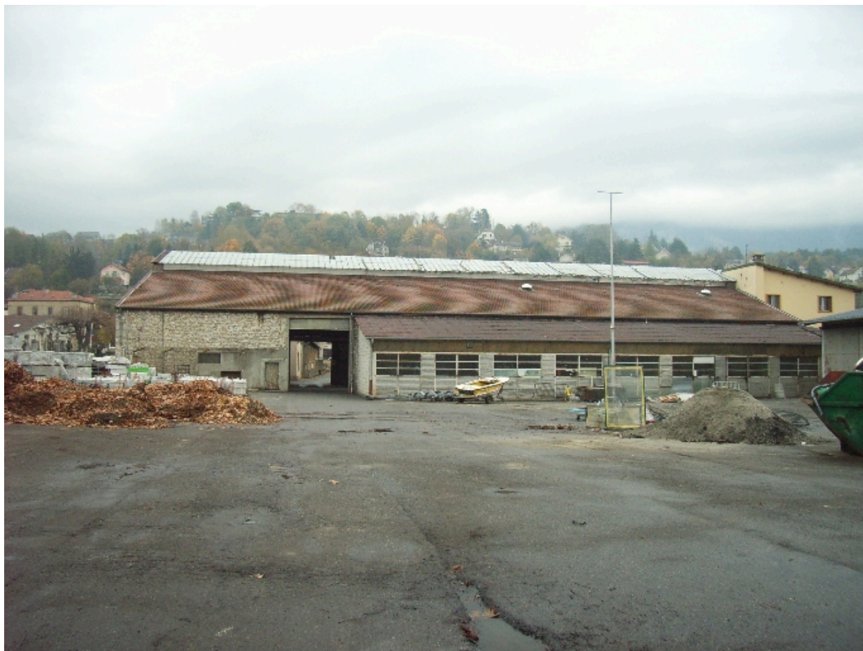
Grande halle, élévation sur la deuxième cour
