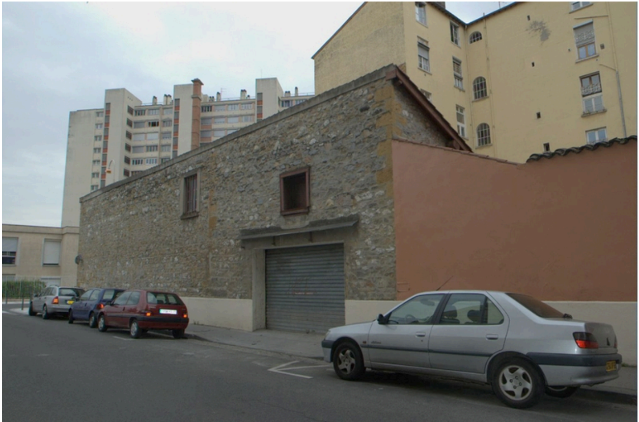
Détail façade nord de l'atelier
