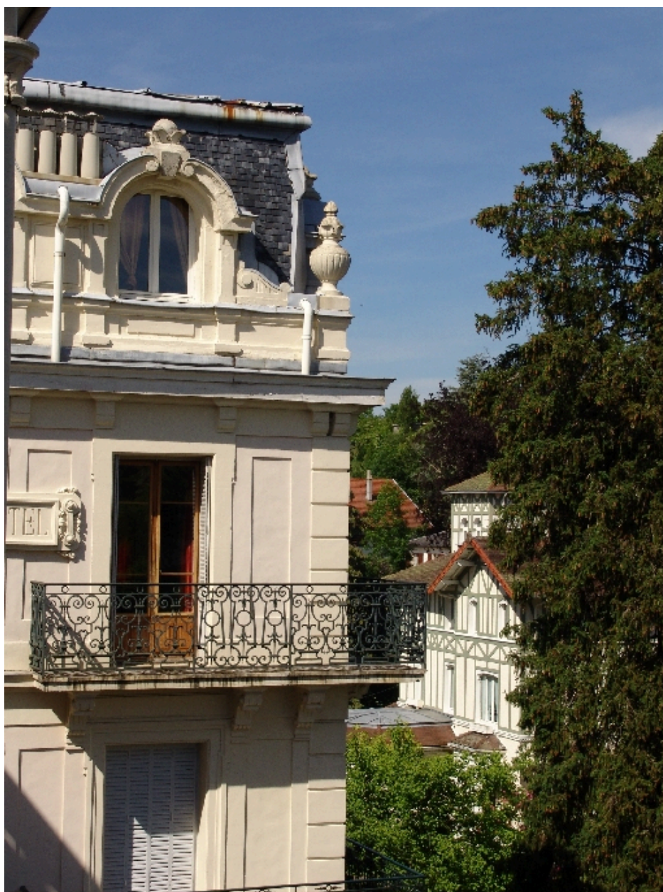
Détail de la façade sud de l'extension nord-est
