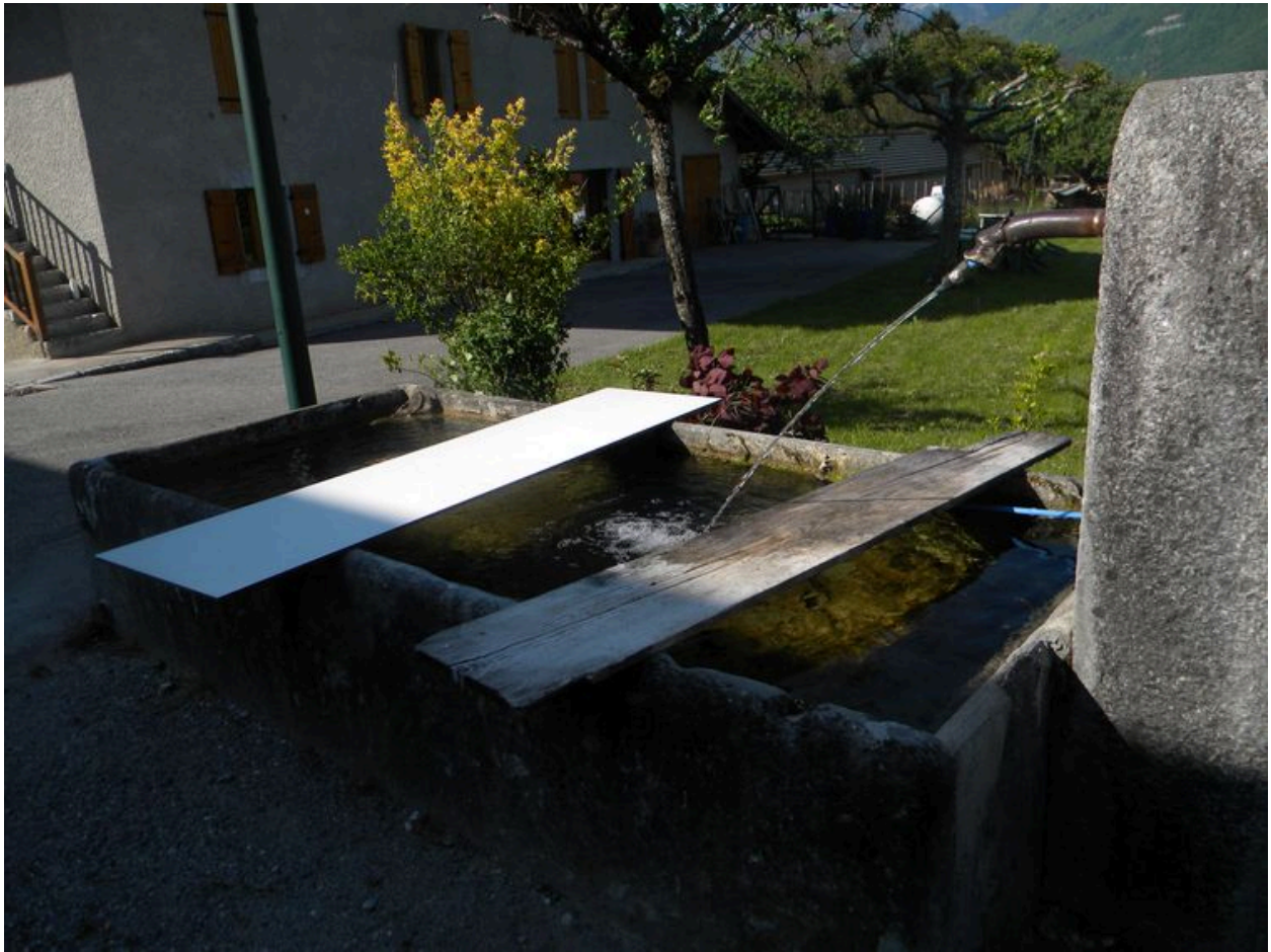
Vue du bassin de profil depuis la route.
