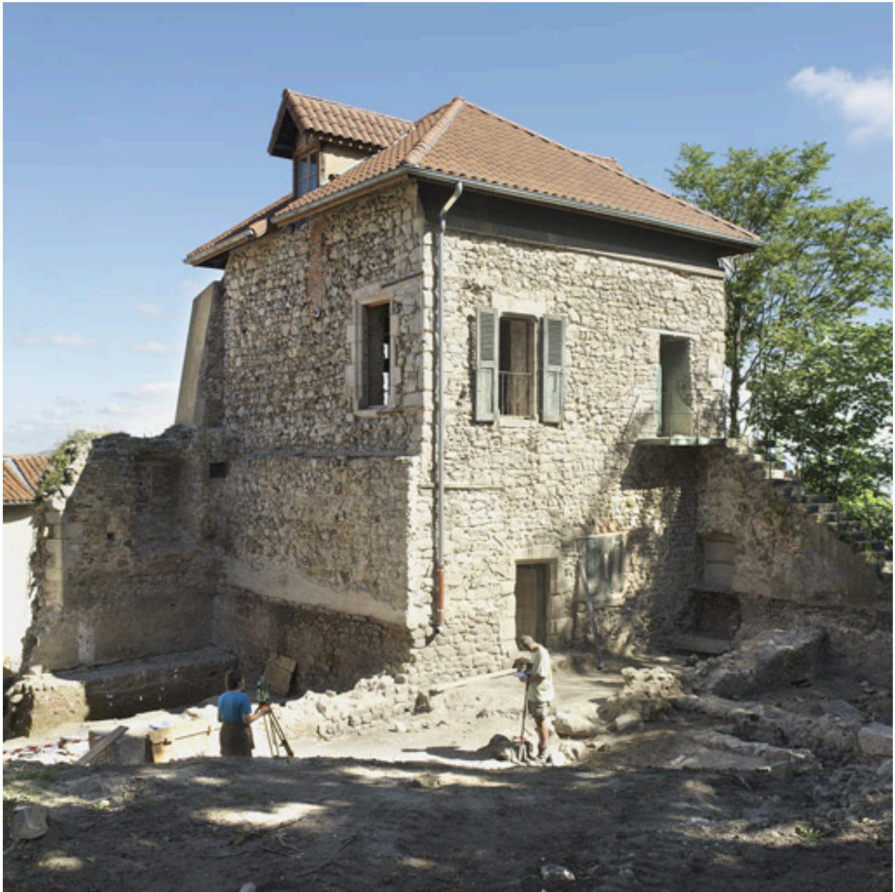
Vue générale de la tour des prisons, façades sud et ouest, à gauche le mur d'enceinte.
