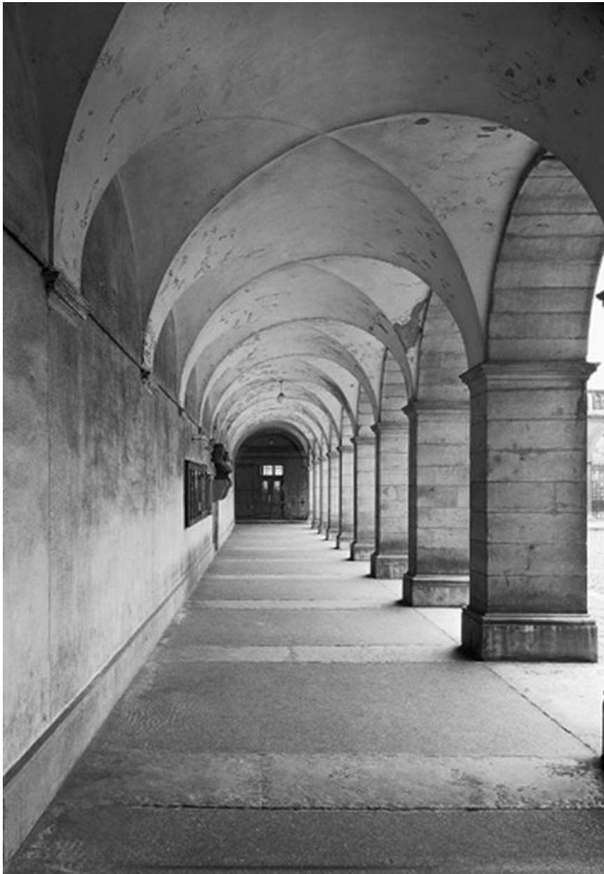
Aile nord, vue intérieure de la galerie du rez-de-chaussée
