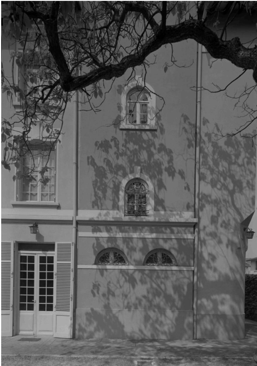
Détail de la tour d'escalier.
