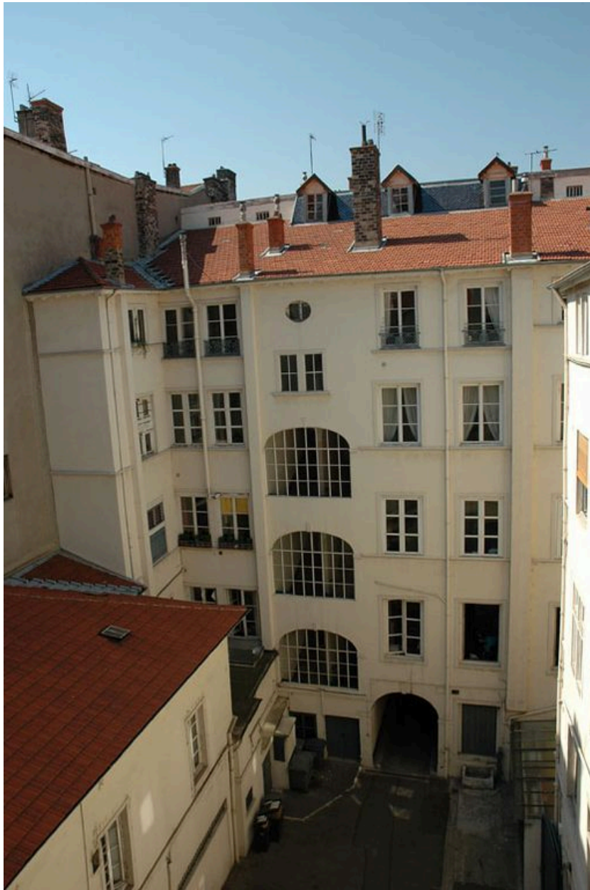
Elévation postérieure du bâtiment sur rue
