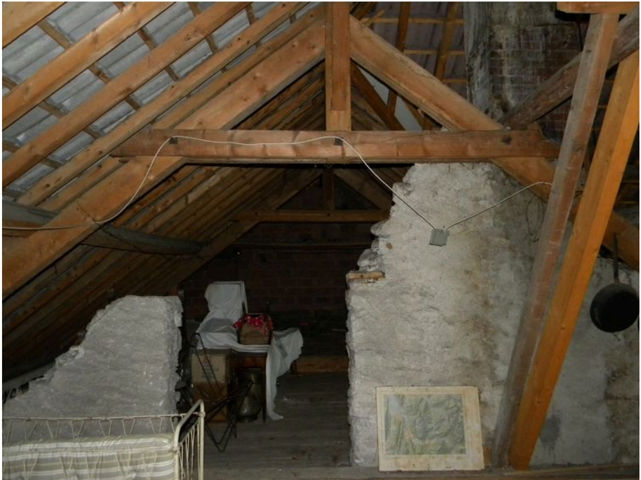
Vue du grenier et de la charpente.
