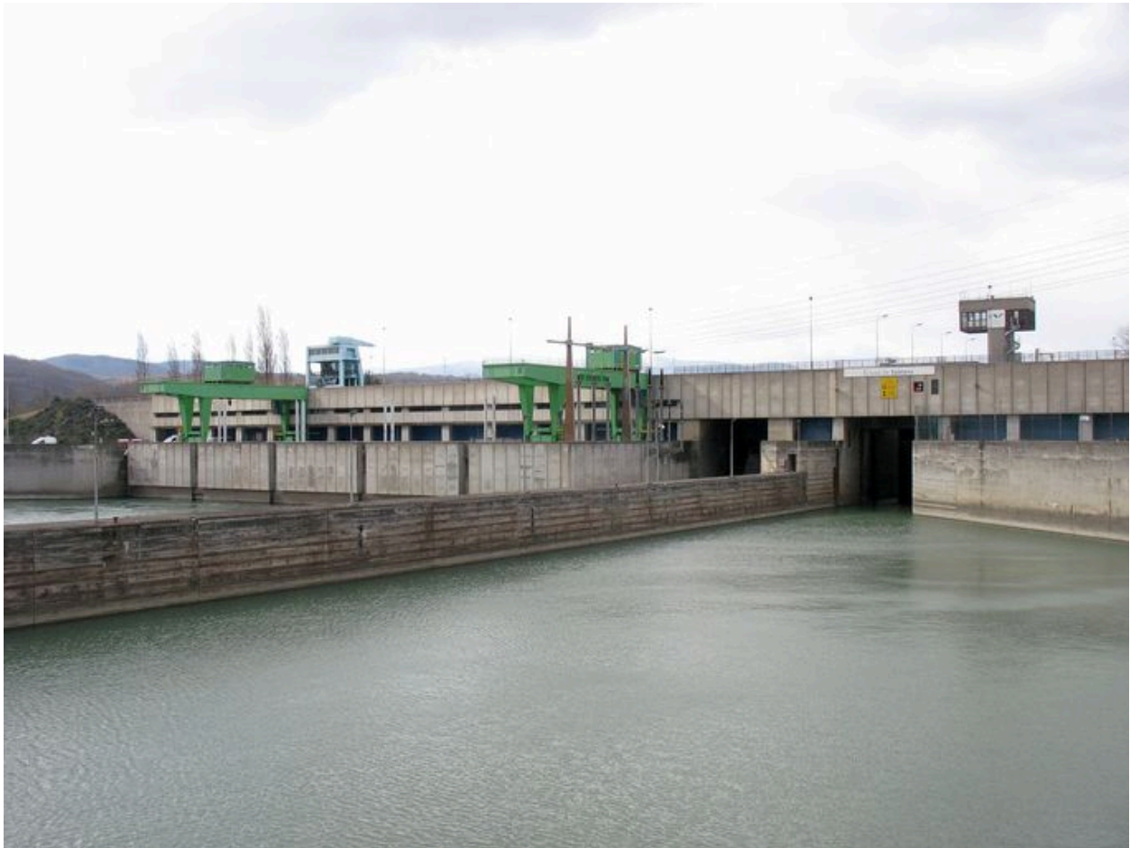
Vue côté aval (depuis la rive gauche)
