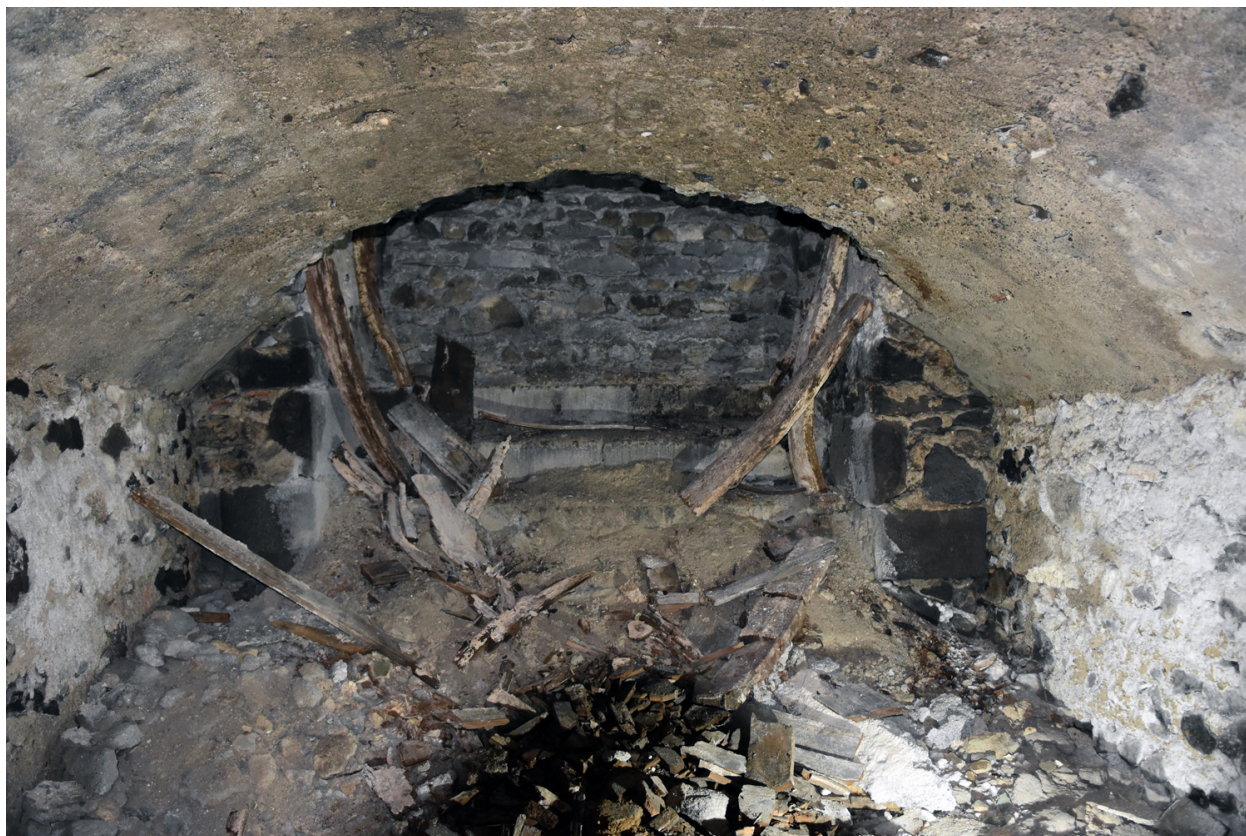
Caves nord, salle n°13 partie ouest ; à l'extrémité, départ d'escalier
