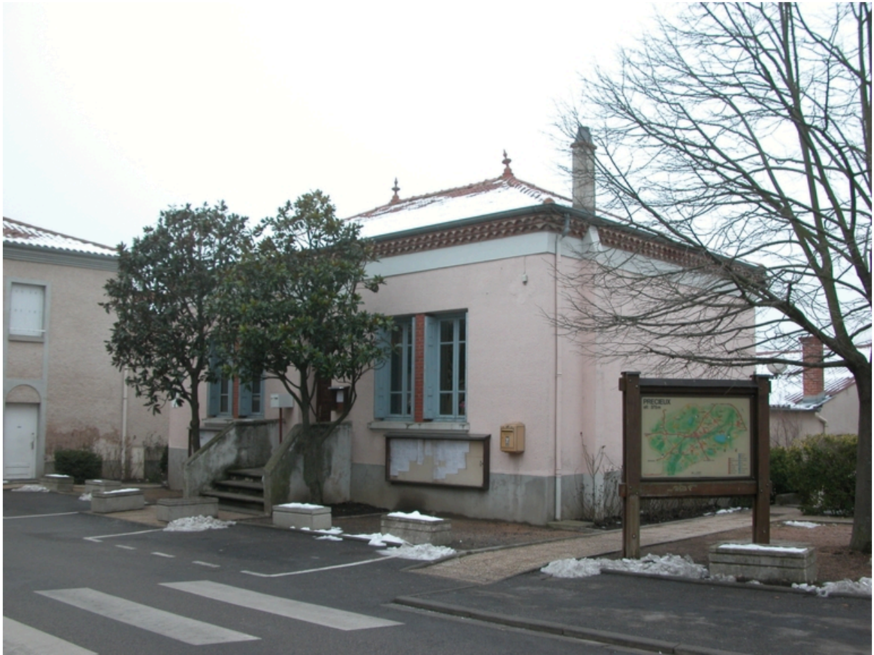
Vue d'ensemble de la mairie (1986 B2 438) depuis le nord-ouest.
