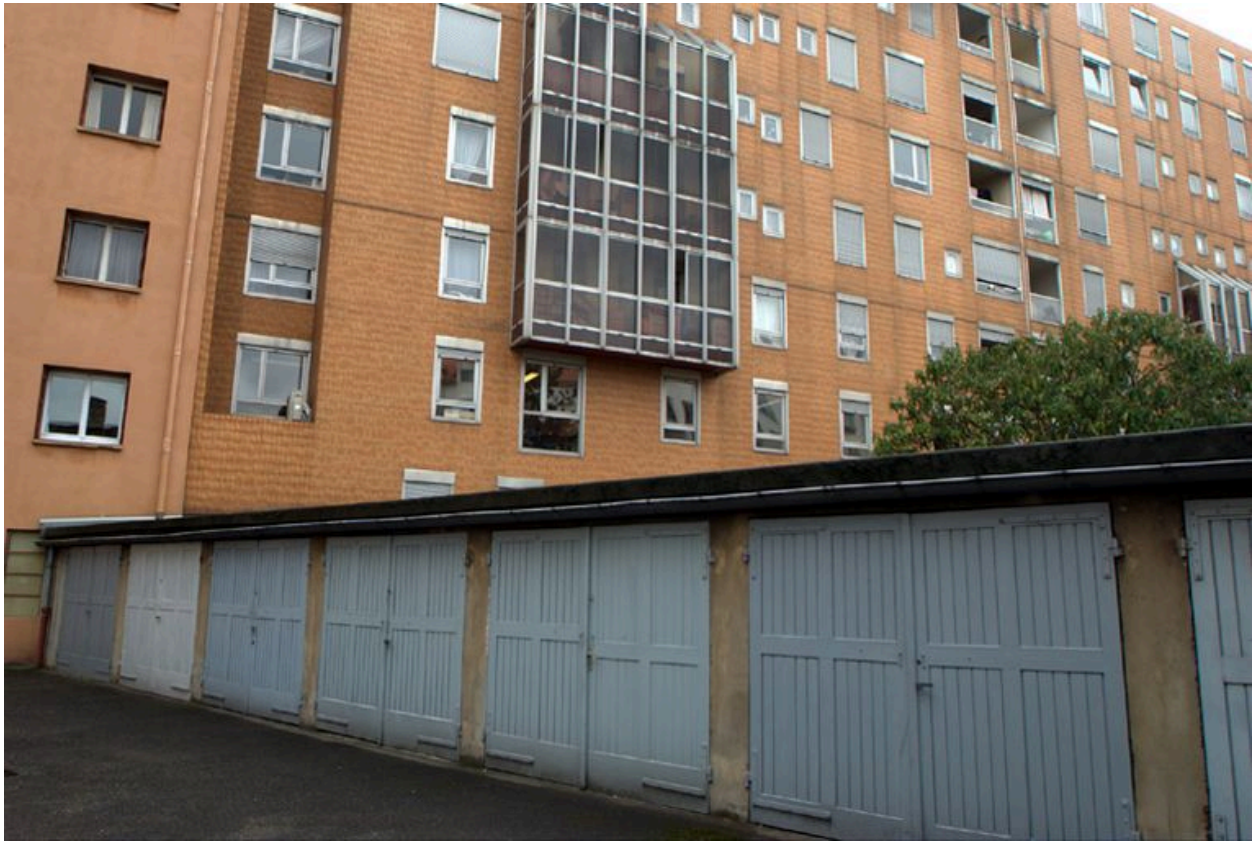
Les garages en limite de propriété au sud de la cour
