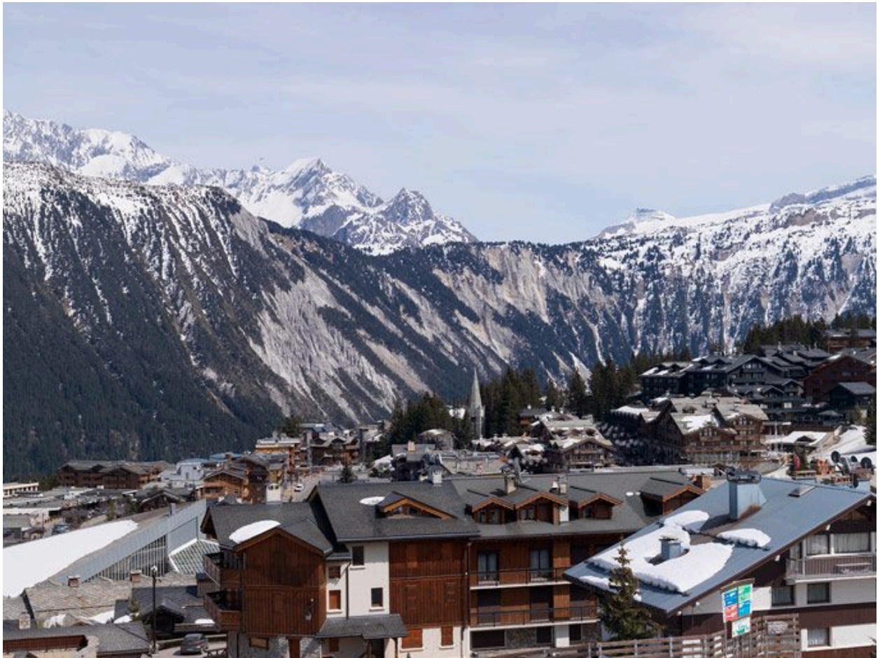
Vue de la station depuis l'ouest
