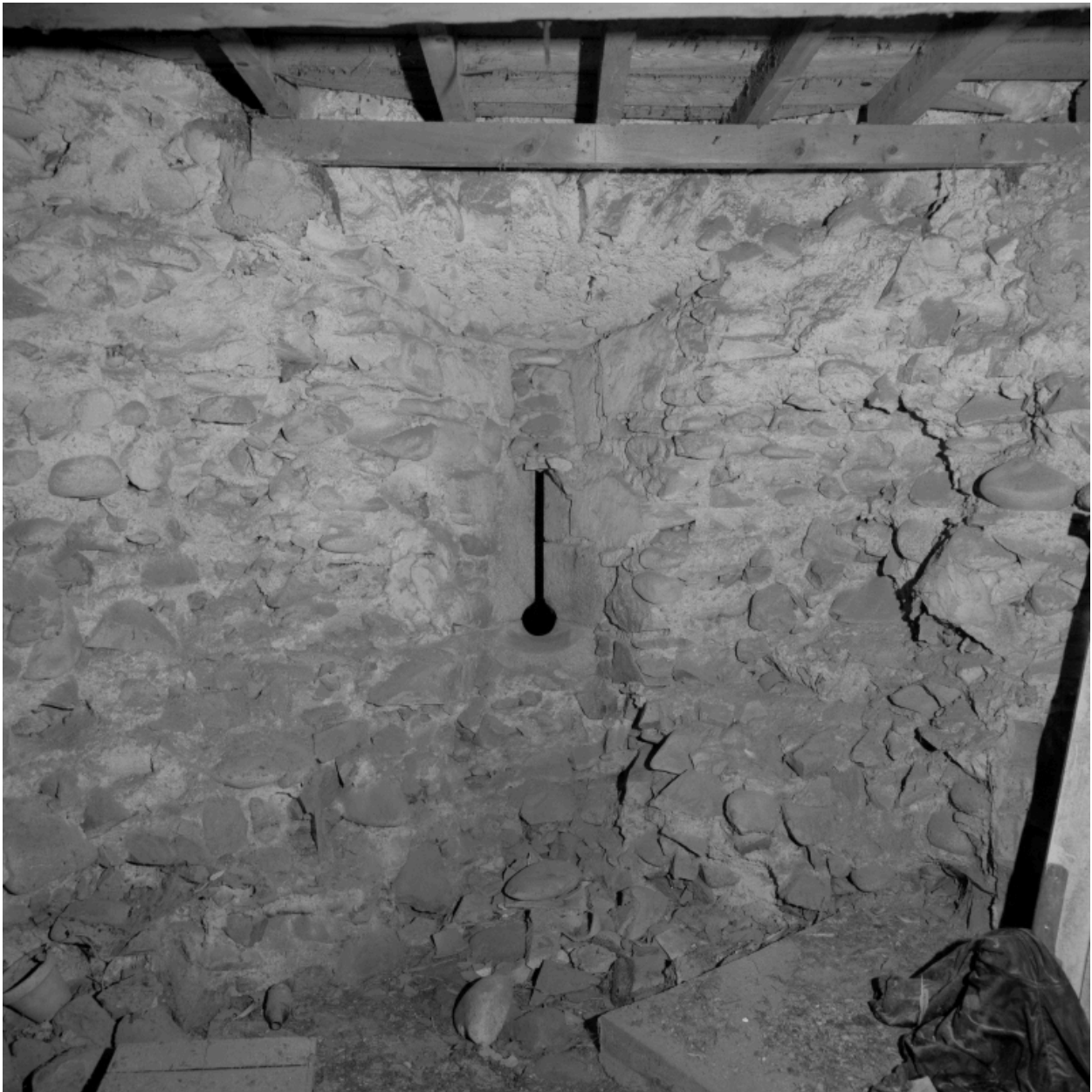
Vue intérieure d'une archère-canonnaire de la tour de la rue du 11 Novembre.
