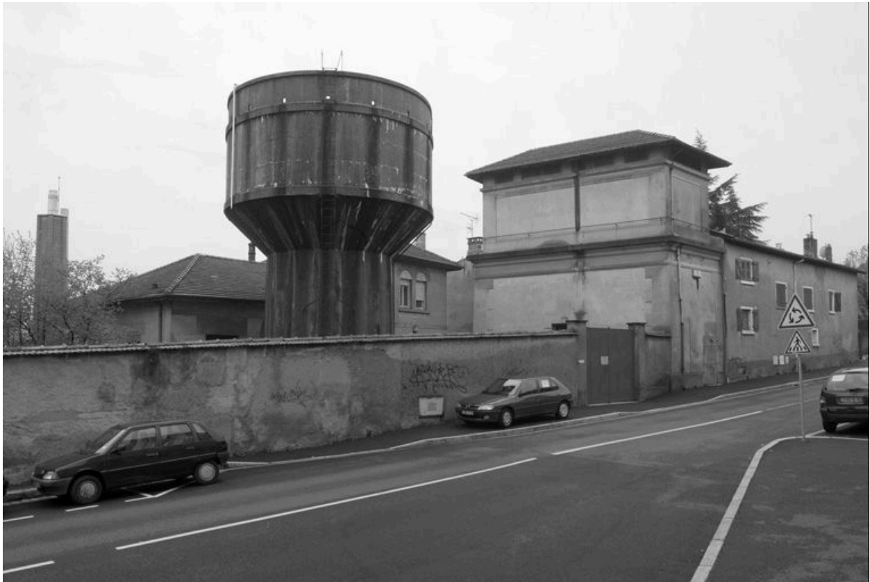
Bâtiments 5 et 19, vue générale
