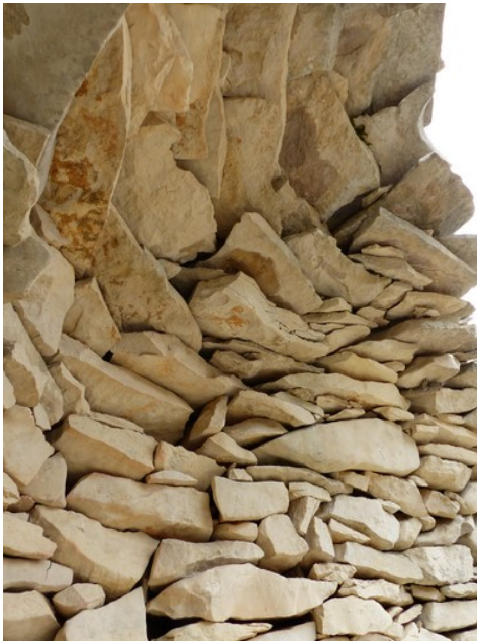
Encorbellement de la coupole d'une cabane, quartier de Croix Blanche.
