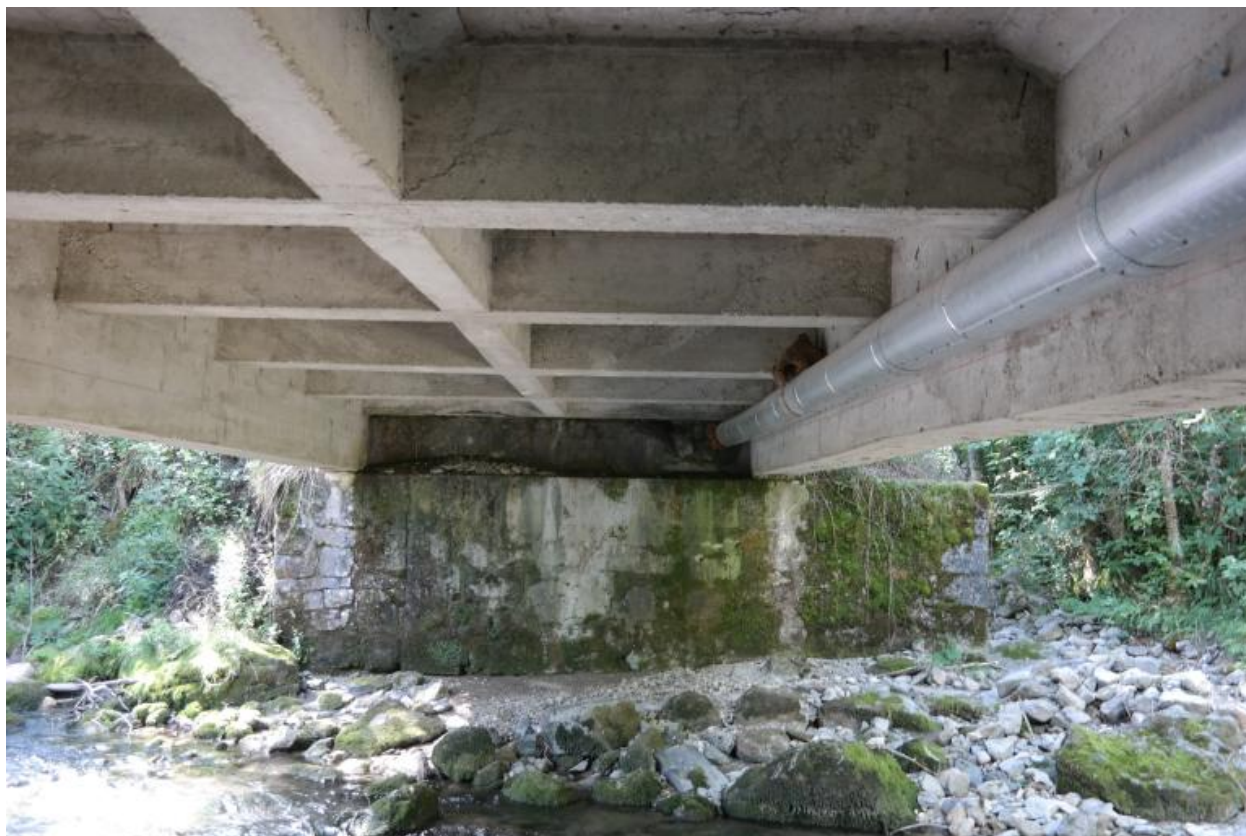
Pont de Passengué, vue de dessous
