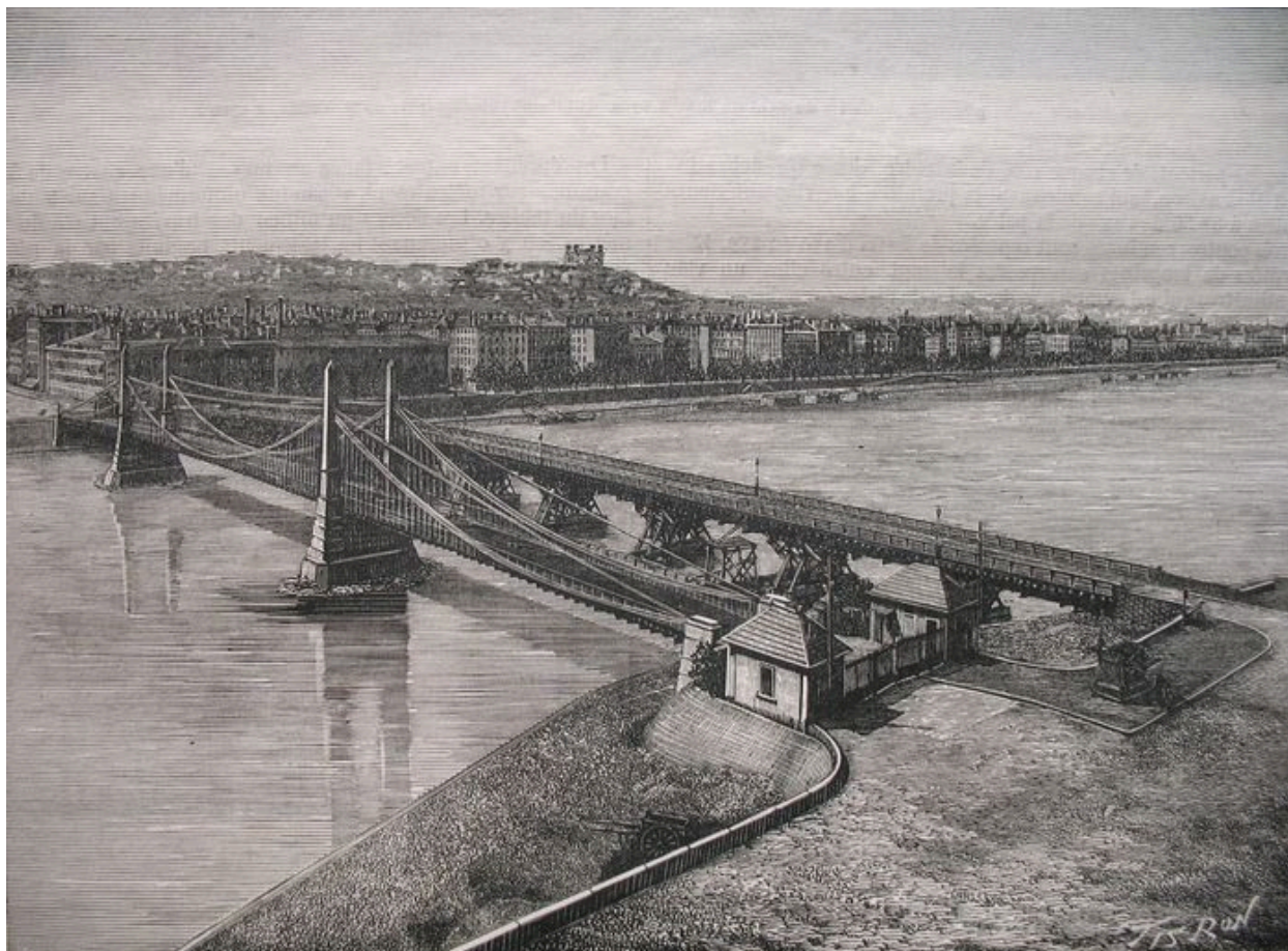
Fig. 1. Vue générale du pont du Midi, à Lyon, et de la passerelle provisoire établie pendant sa reconstruction (d'après une photographie de M. Garcin, à Lyon) (extr. de : NANSOUTY, Max de. In Le Génie civil, t. XIII, n° 23, 6 octobre 1888, p. 353)
