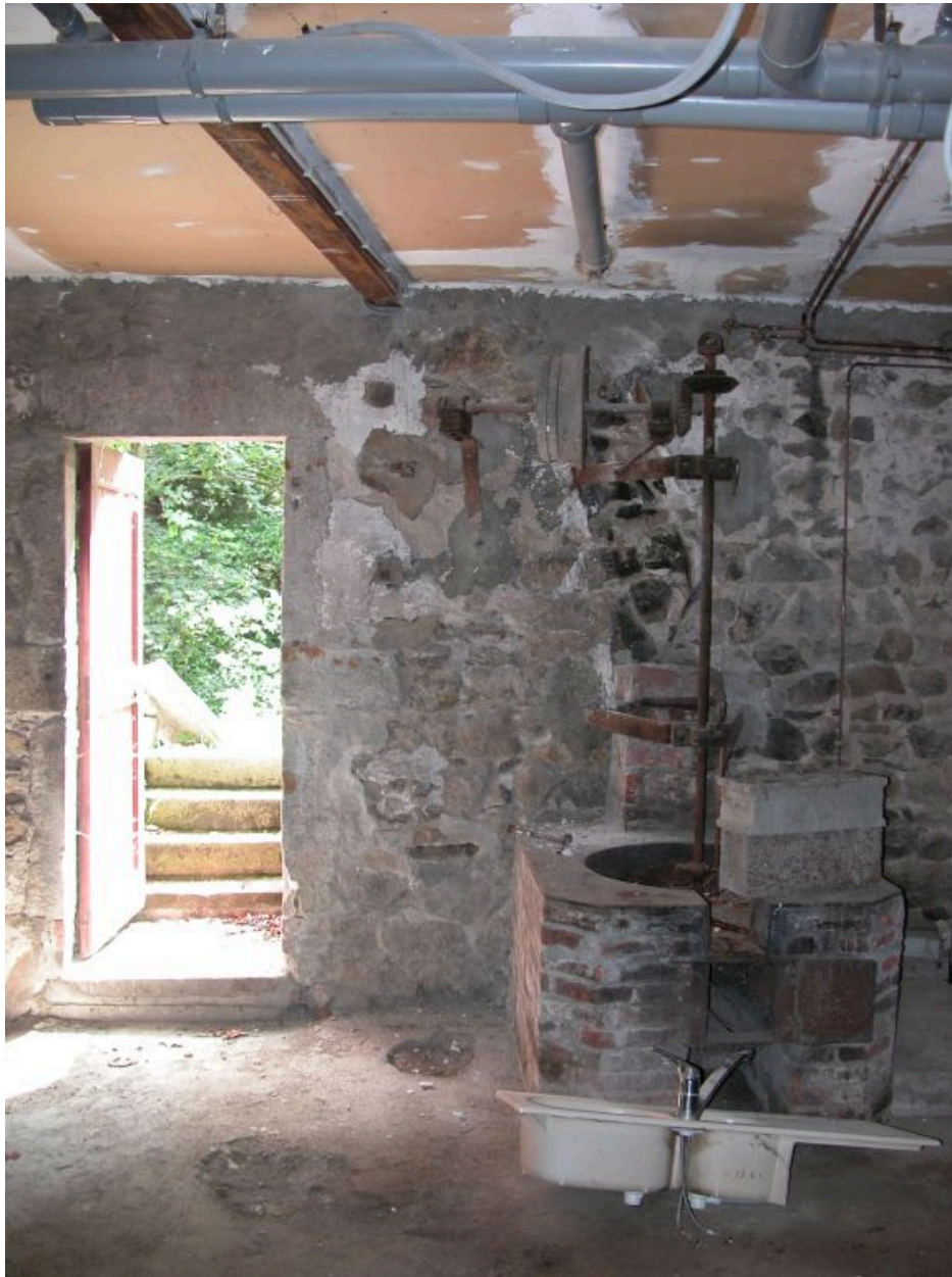
Vue d'ensemble de la cuve à chauffe.
