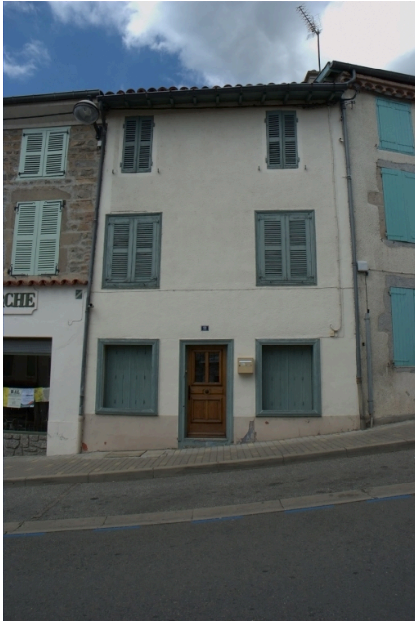
Îlot 6. Carnot (place) 11. Vue générale de la façade sur rue.
