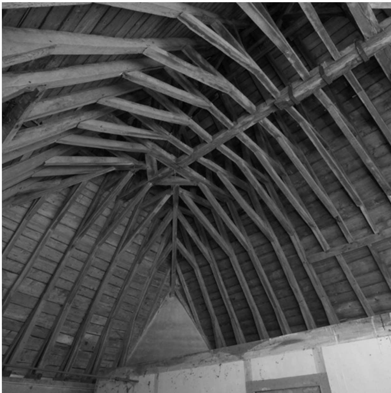
Vue intérieure : vue d'ensemble du comble et de la charpente du corps central.
