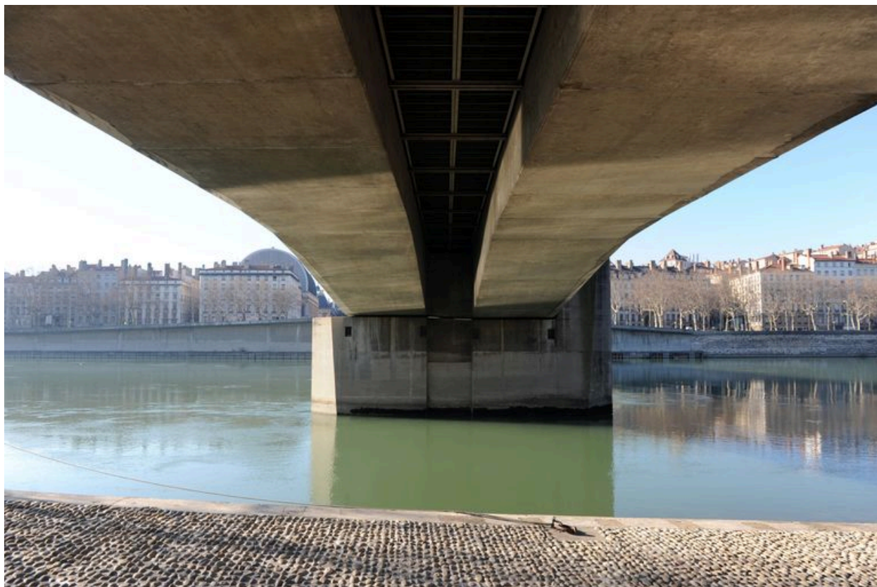
Vue partielle, de dessous, tablier et pile (depuis la rive gauche)
