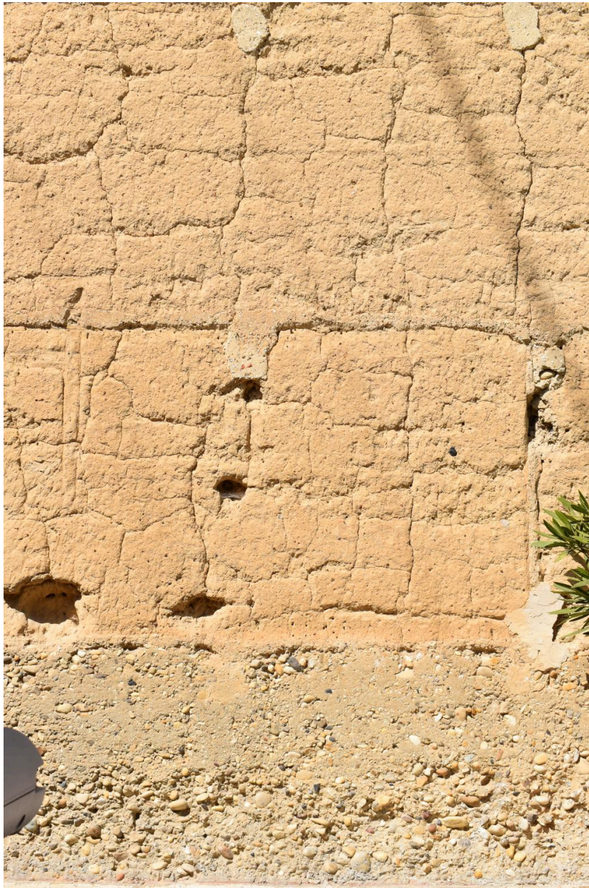
Détail : pisé avec soubassement béton de chaux
