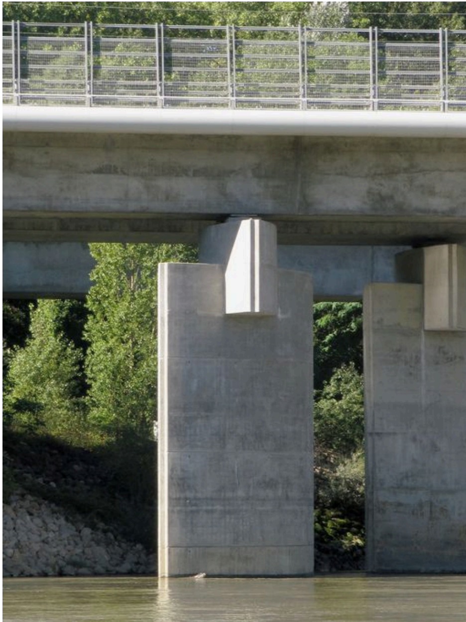
Vue d'une pile, partie du pont sur le canal de Miribel (depuis la rive droite)
