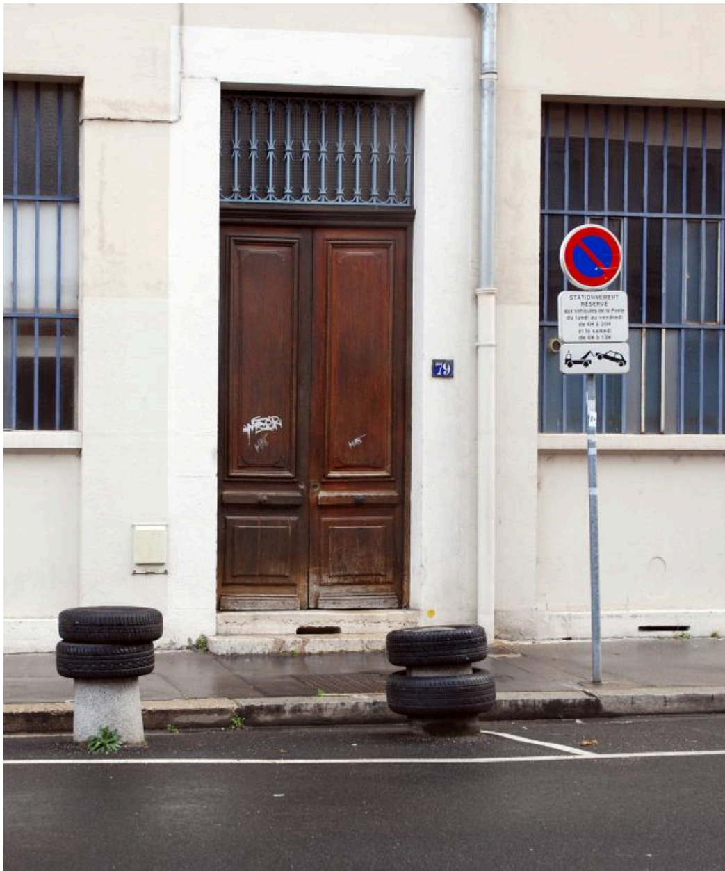
Immeuble : détail de la porte d'entrée
