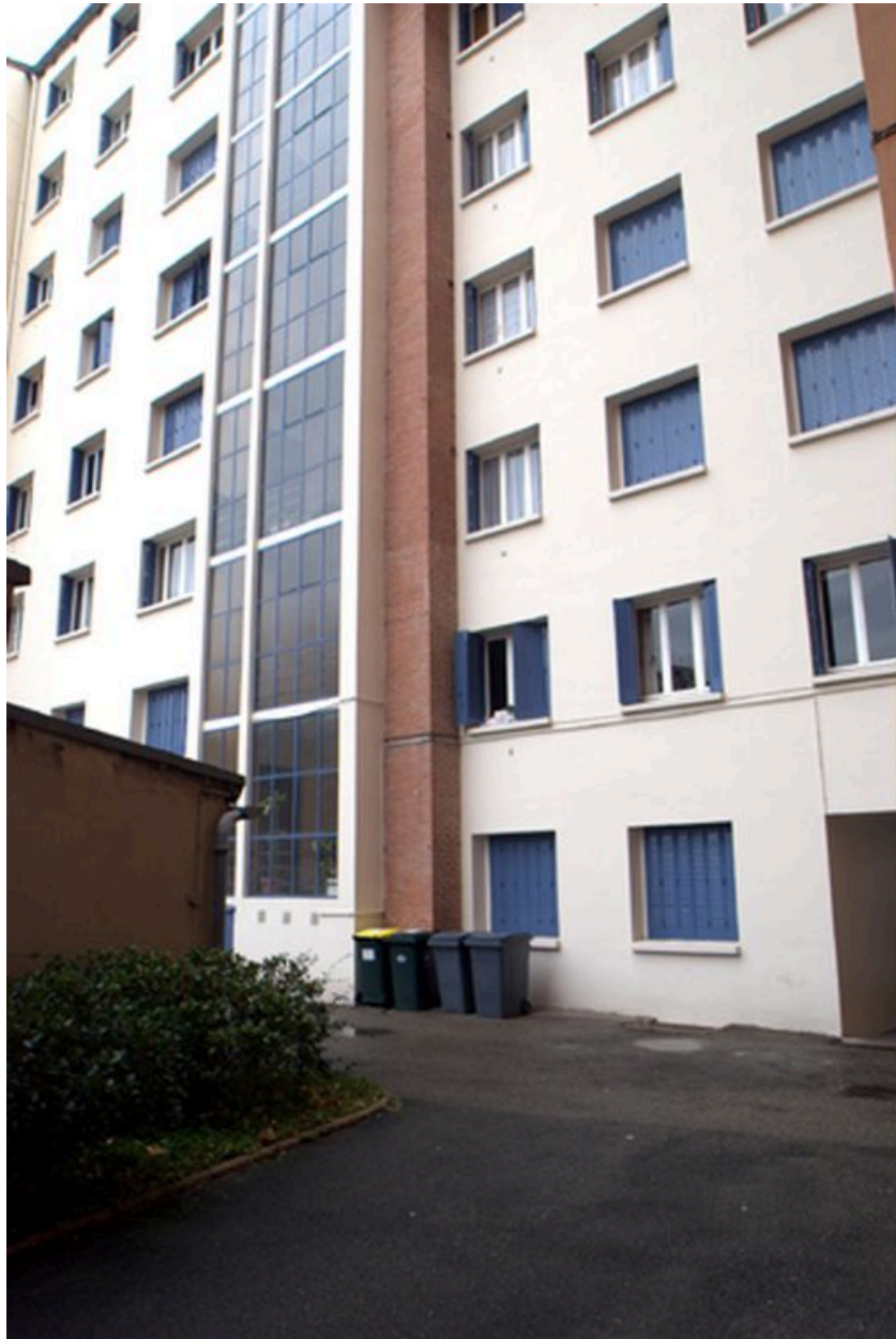
Elévation postérieure. La cage d'escalier demi-hors-oeuvre vitrée
