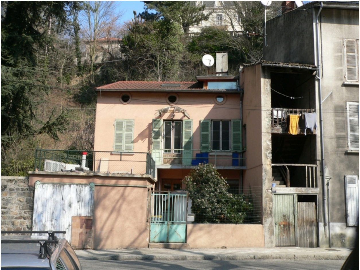
Façade principale sur rue
