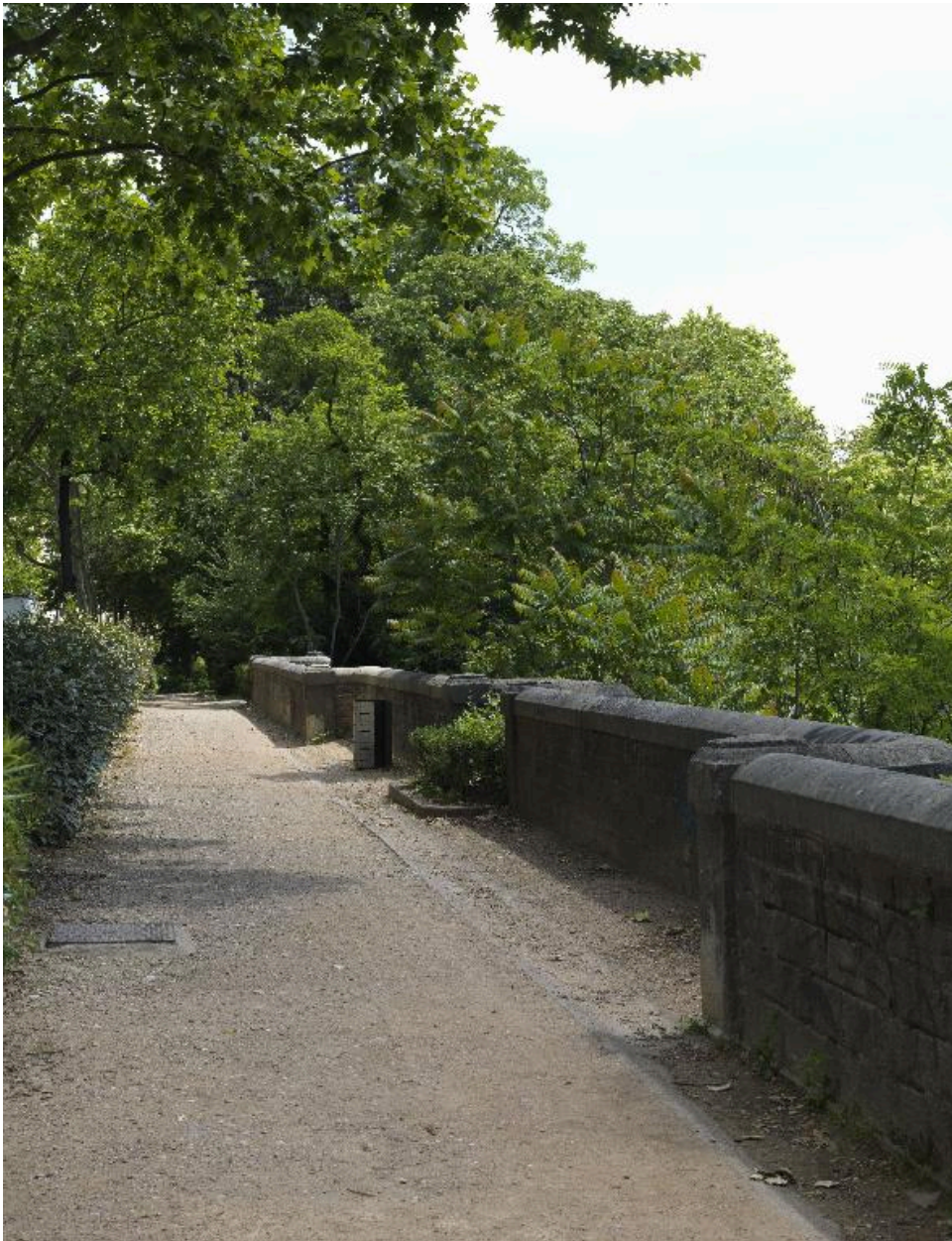
Le pont reliant les deux parties du jardin, suivant l'axe ouest-est
