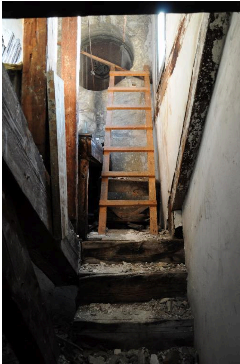
Accès à l'horloge depuis les combles
