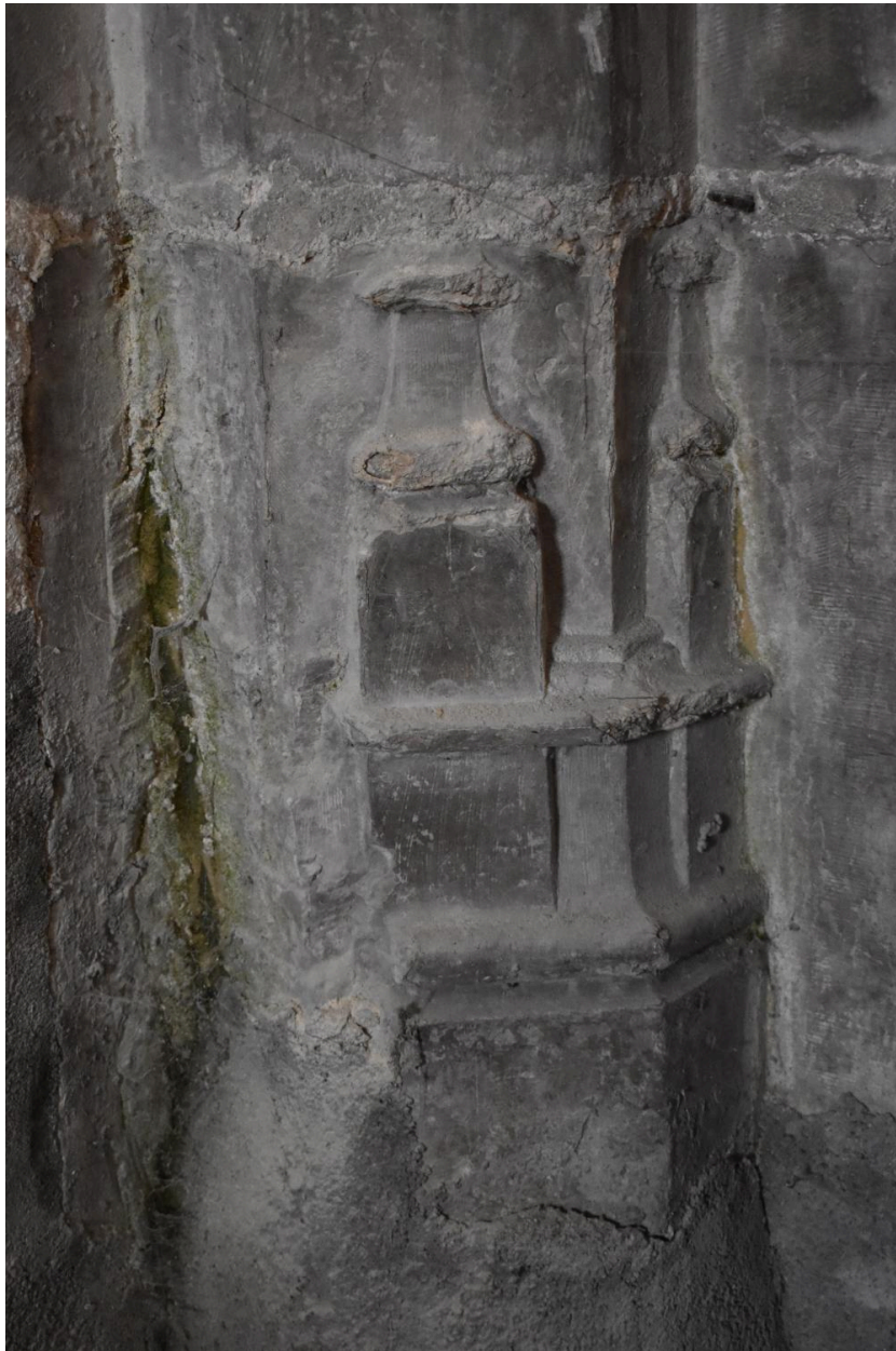
Détails des bases d'arcs et nervures à l'angle nord-est de la chapelle de la Beaume.
