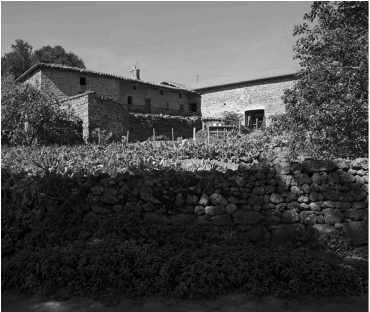
Vue d'ensemble de la cour depuis le sud-est.
