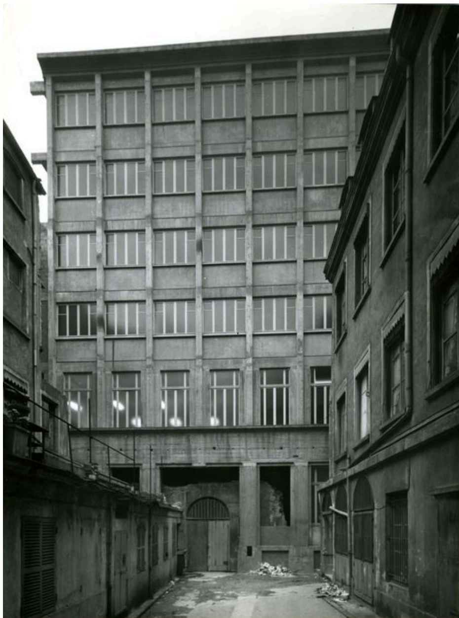
Elévation antérieure du bâtiment Isara (1ère tranche), cour du 12 rue Alphonse Fochier avant démolition, photographie ancienne, ca 1970
