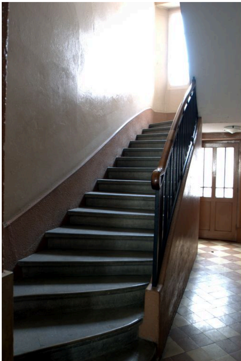
1ère volée de l'escalier
