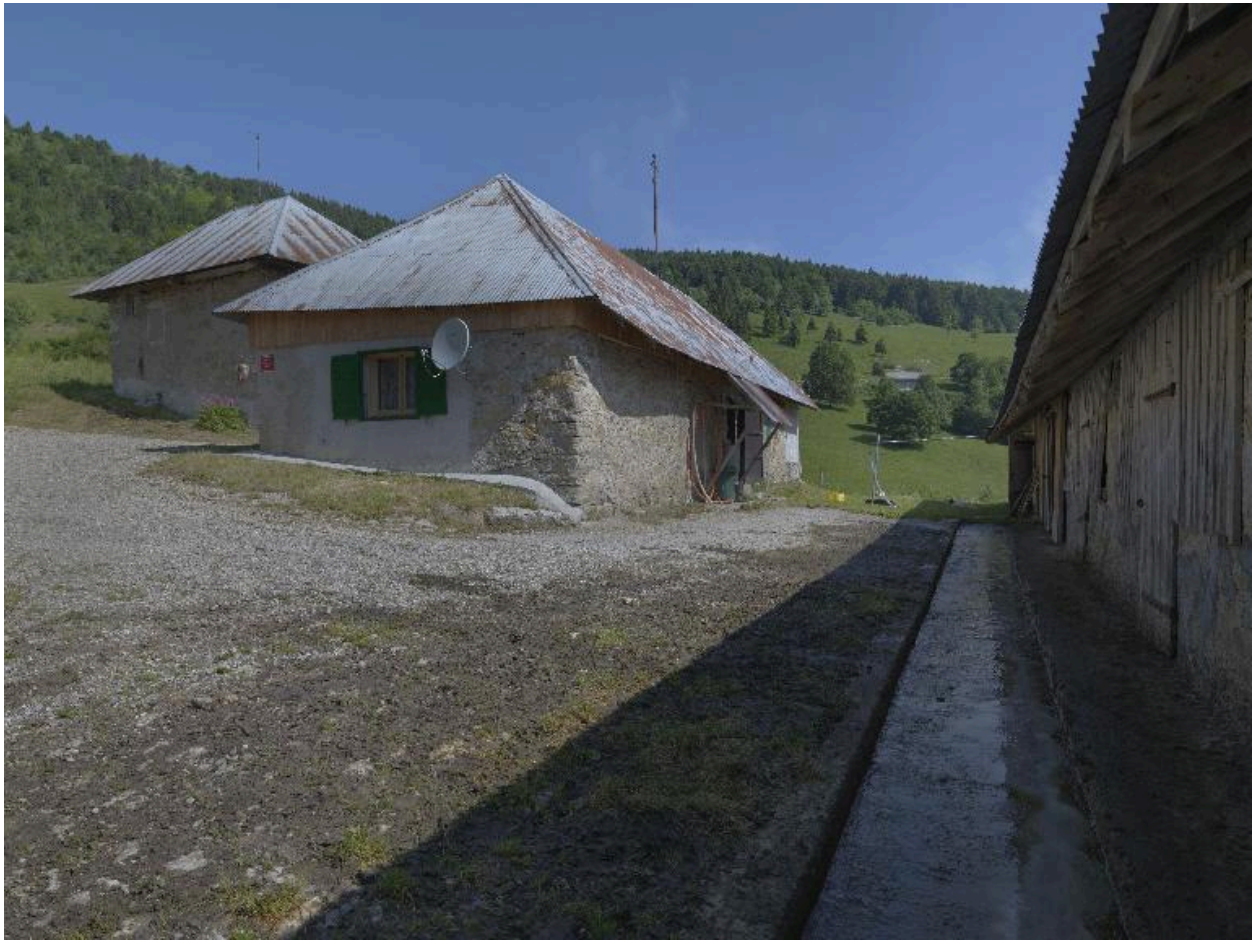
Vue d'ensemble depuis le sud ; à droite, l'étable.
