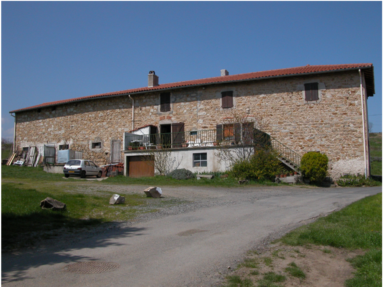
Vue d'ensemble du bâtiment sud, depuis le sud.
