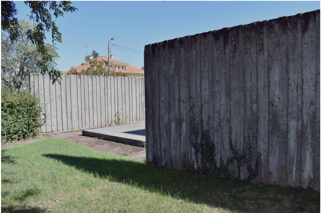
Détail des effets de relief sur les murs en béton
