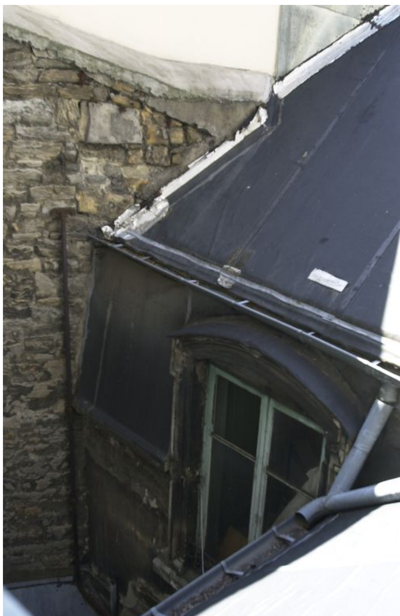
Détail d'une fenêtre de la loge de concierge
