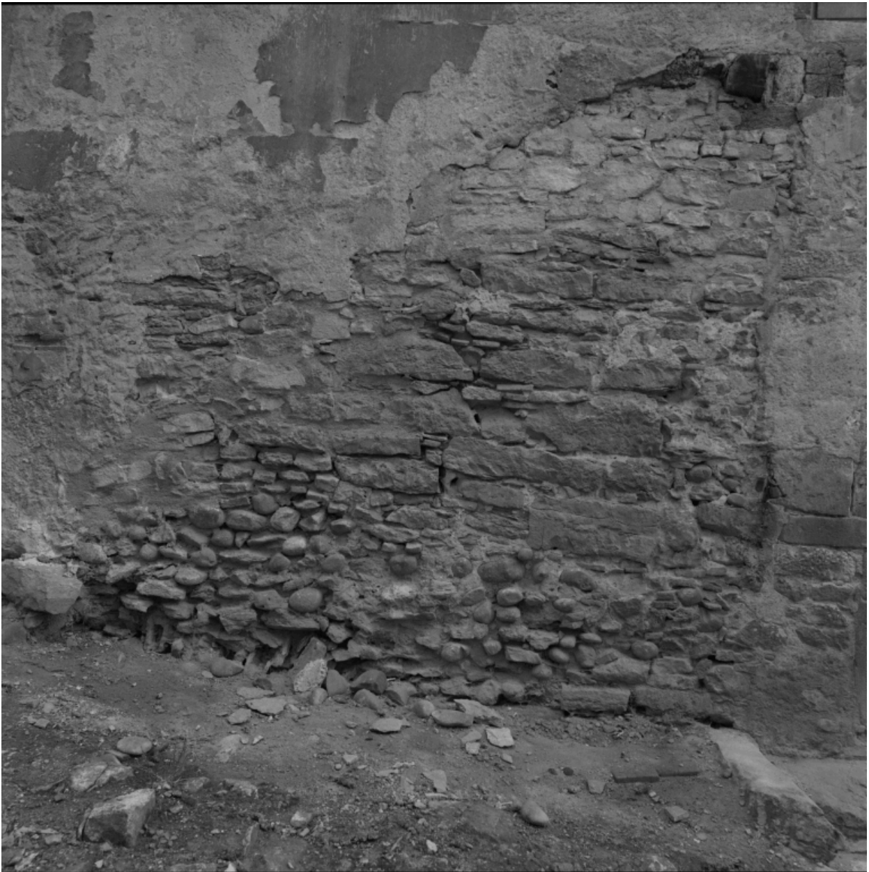
Maison de type I, 5 rue Casse-cou : détail de matériaux employés en appareil mixte (galets, calcaire, pierre dorée, brique, tuileau)
