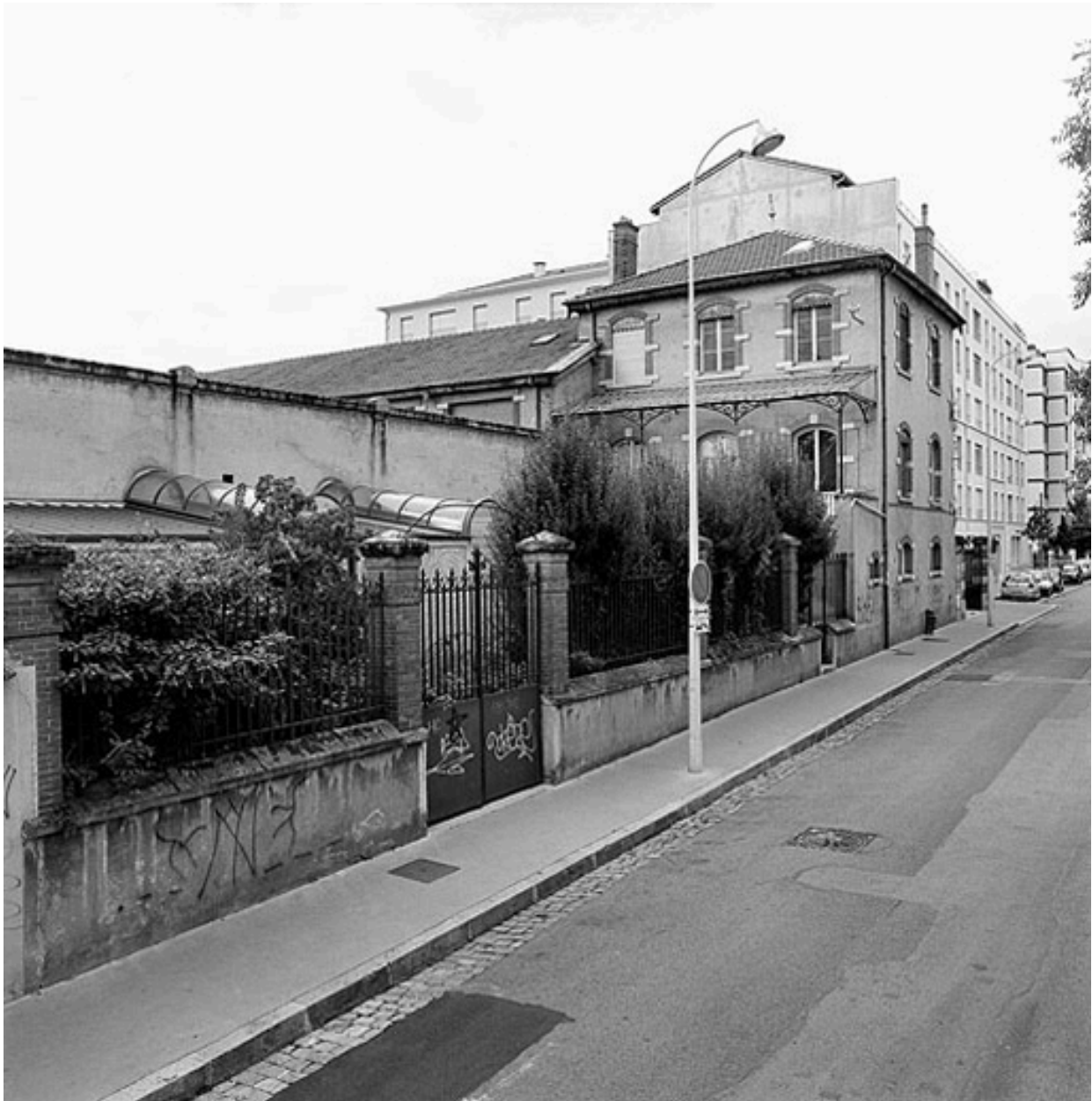
Vue d'ensemble sud est
