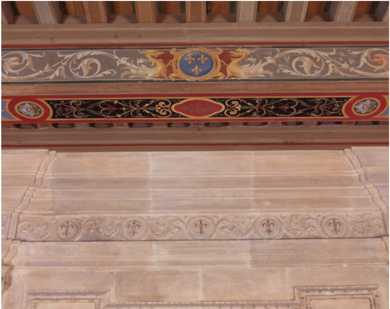
Premier étage. Salle du roi. Poutre peinte et corniche de la cheminée.
