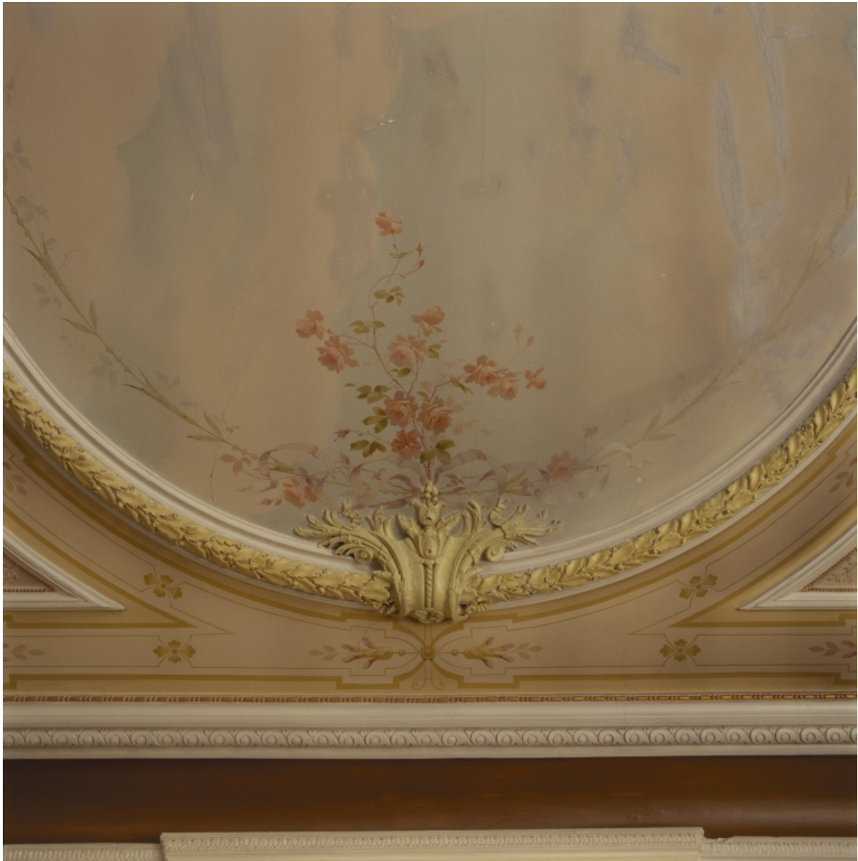
Détail d'une agrafe en stuc traversée par un cordon de feuilles de chêne mouluré et d'un bouquet peint.
