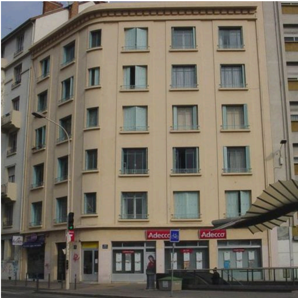
Vue générale de l'élévation
