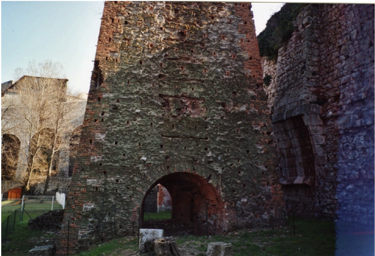
Détail haut fourneau
