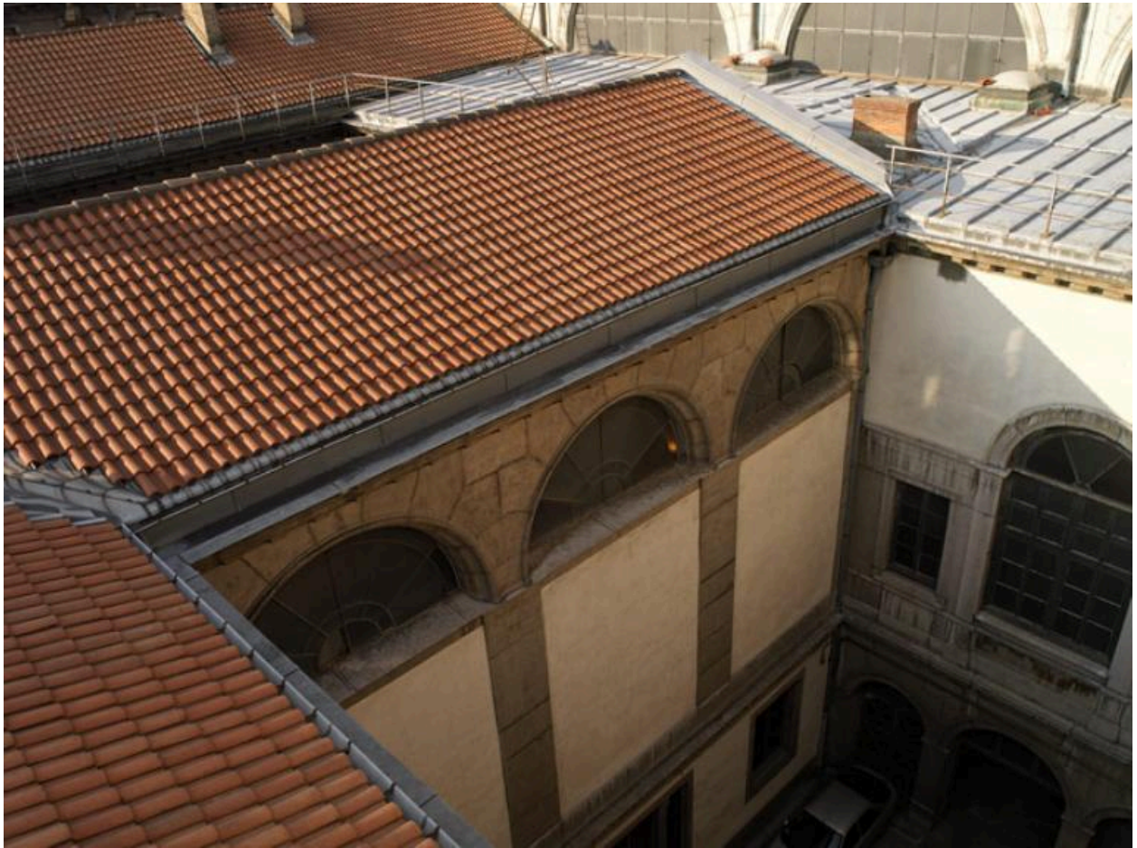
Cour sud-est, vue partielle
