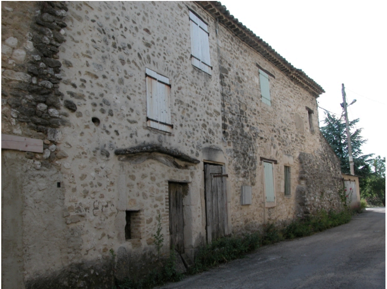
Elévation d'une maison de la Grande rue (F 692-690) prise du nord-est.
